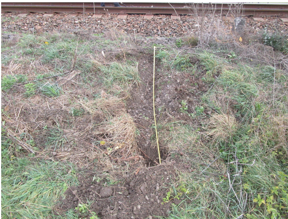
Obr. č. 3.: Pohled na provedený kopaný zářezem násypovým tělesem, výšky cca 1,5 m.
